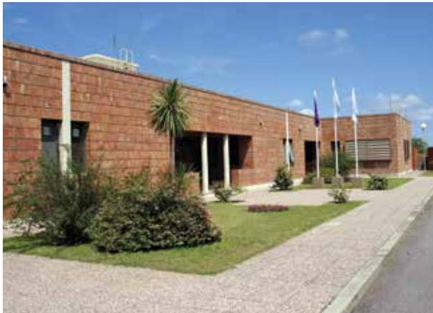
Edificio del Instituto de Altos Estudios Espaciales 'Mario Gulich'
